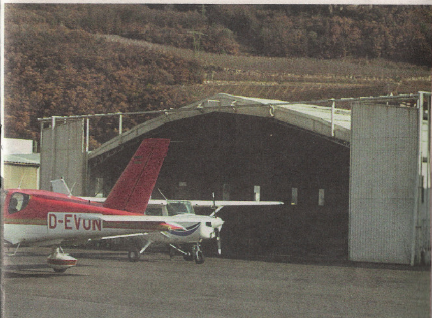
Hangar steht. Die geplanten Wartungshallen für die Air-Alps-Flugzeuge könnten an die zwei Mio. Euro kosten.
